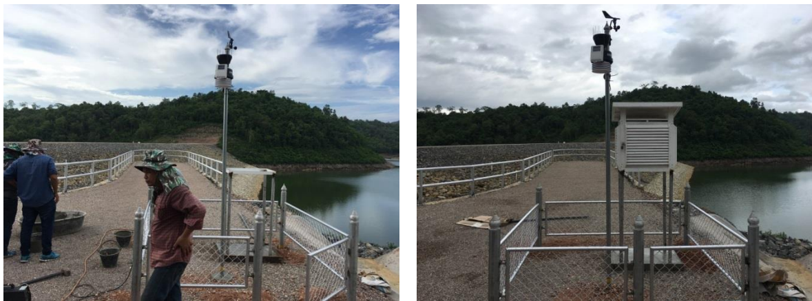
รูปที่ 5.2.1 – 2 การติดตั้งเครื่องวัดอุตุนิยมวิทยาบริเวณห้วยงานโครงการ
